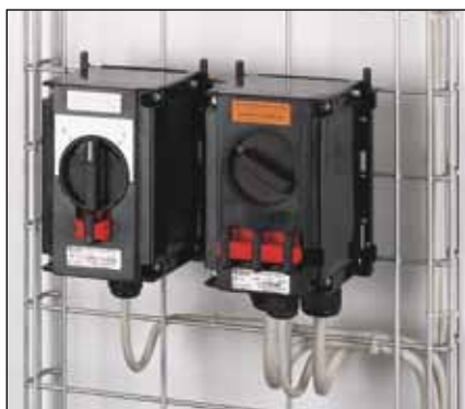
Monterad på trådstege
